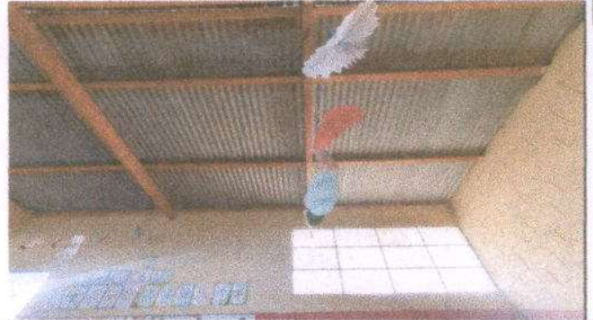
Foto 2: Sustitución de lámina por lámina troquelada aluzinc calibre 26 Escuela
