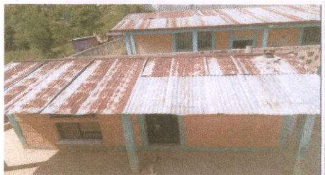
Foto 4: Sustitución de lámina por lámina troquelada aluzinc calibre 26 Cocina Escolar
