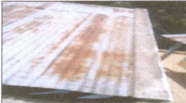
Foto 1: Sustitución de lámina por lámina troquelada aluzinc calibre 26 Escuela
