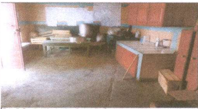
Foto 5: Sustitución de piso de granito Cocina
