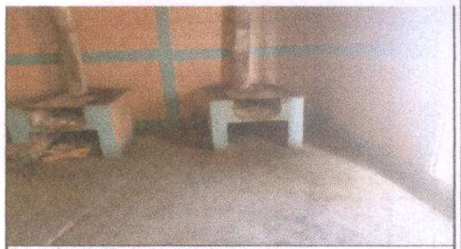
Foto 6: Sustitución de chimenea de concreto
